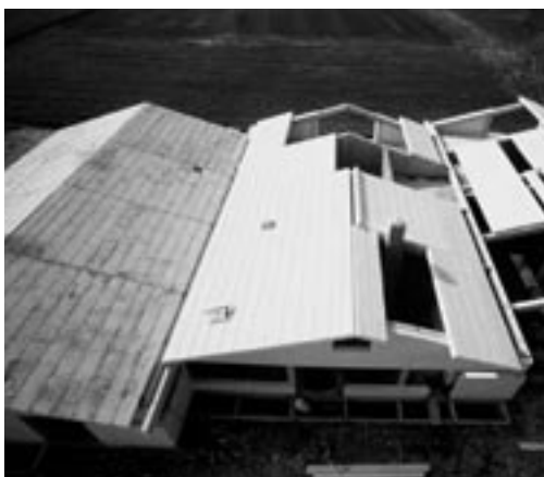
HEBEL Dachplatten als massives Dach im Wirtschaftsbau.
