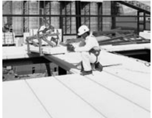
Verlegen von HEBEL Dachplatten mit Verlegebügel.
