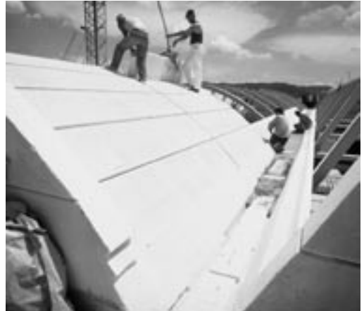
Halbrundes Sheddach aus HEBEL Dachplatten.
