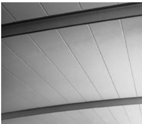
Innenansicht eines HEBEL Daches.
