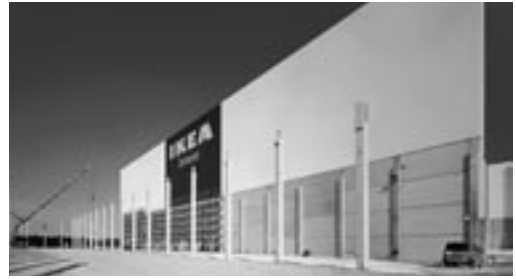
Sicherheit durch HEBEL Komplextrennwände beim Bau des IKEA Zentrallagers in Salzgitter.
