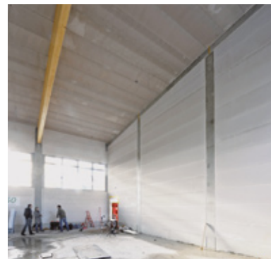
Die Luftdichtheit wurde mit einem Blower-Door-Test gemessen.
