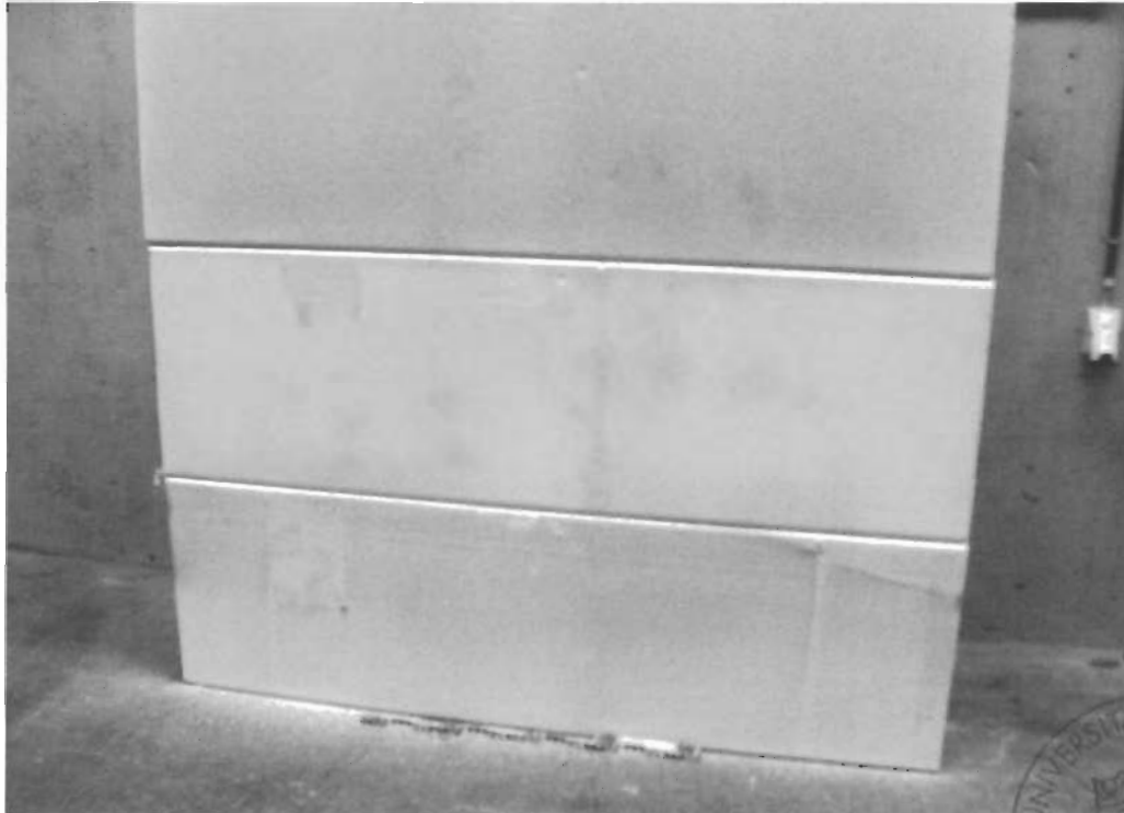
Bild 1 Gesamtansicht: Sporthallenwand „Hebel Porenbeton Wandplatten P 3.3 / 0,50“
