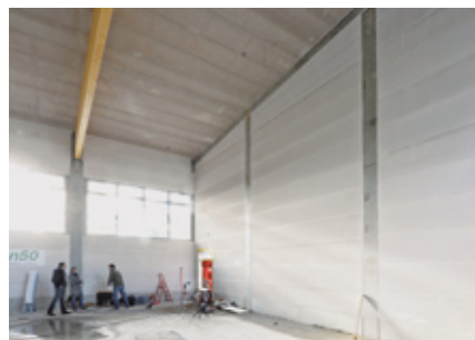
Innenansicht der Halle
