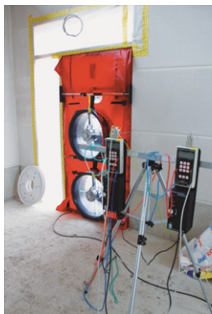
Versuchsaufbau mit BlowerDoor-Messsystem
