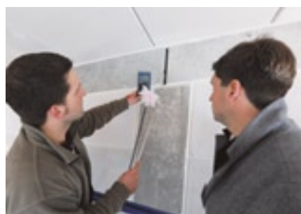
Aufspüren von Leckagen mit Federstab und Thermoanemometer
