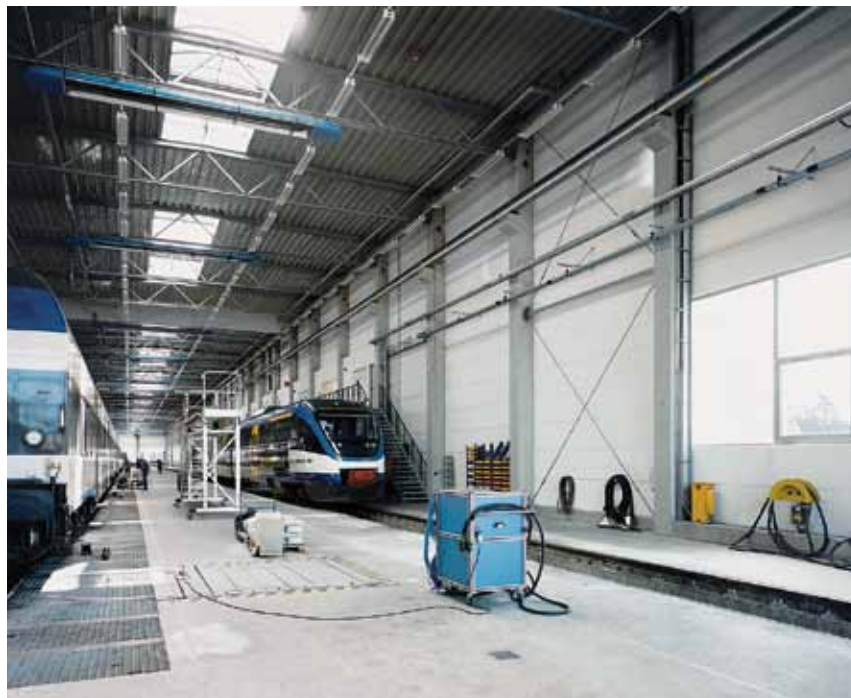
Die Halle wurde aus Sichtbetonfertigtstützen und Außenwänden aus Porenbeton realisiert.
